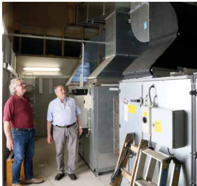
Eine gigantische Lüftungsanlage schützt die Gesundheit der Schießsportler.
